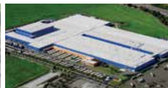
Hörmann KG Ichttershausen, Allemagne
